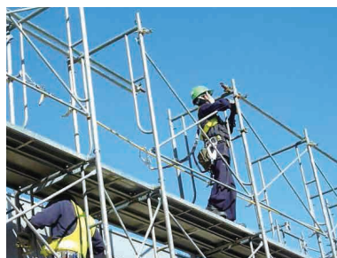
あしばかいたい 足場解体
