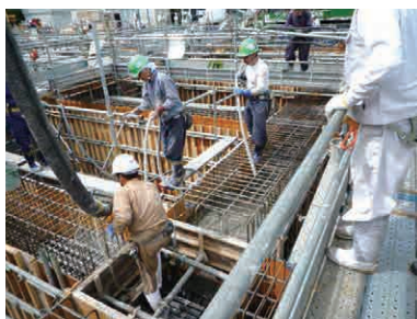
だせつ コン打設
